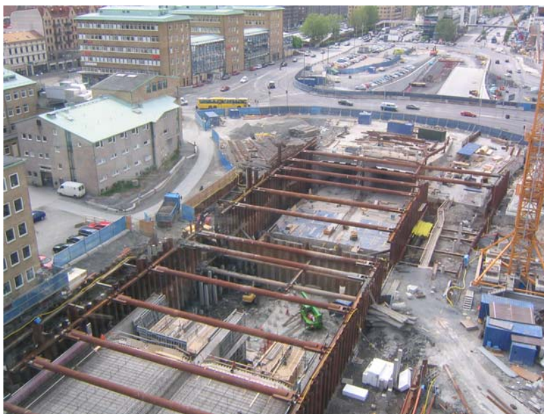
Figur 3.27 Etapp 3A under byggtiden (Efter A Kullingsjö)
