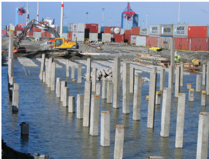
Figur 3.39 Slagna, ej ännu kapade, pålar och gjutna pålplattor vid översvämning från älven
